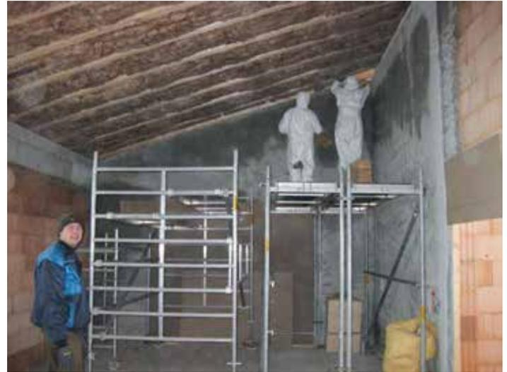
*Kopfüber werden Dämmung und Dampfsperre angebracht. Alles in allem eine recht kratzige Angelegenheit, daher der weiße Vollschutz.*
