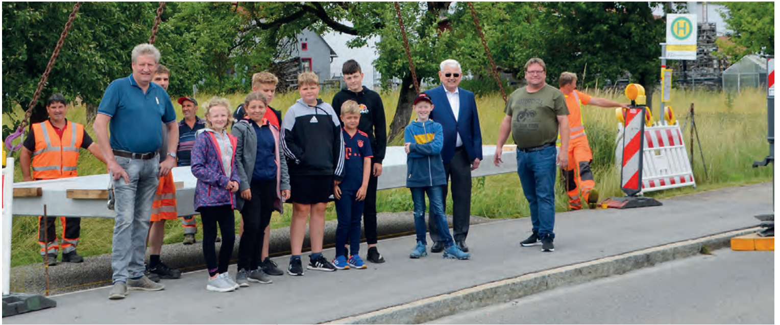
Die Kinder freuten sich schon mal über den Baubeginn.
